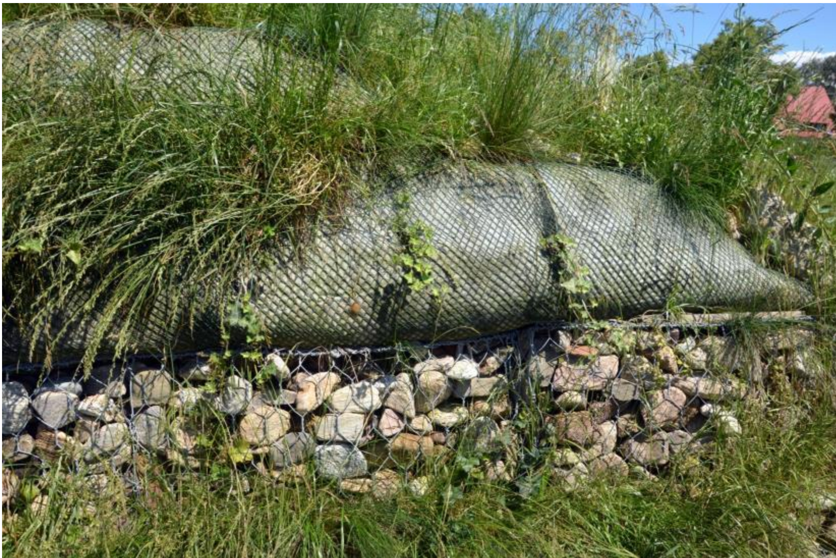
Grunt zbrojony i gabiony
